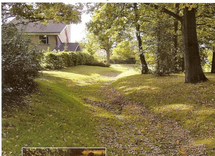
De constructie van de wadi's in de wijk Ruwenbos in Enschede van eind jaren '90 heeft een voorbeeldfunctie. Het regenwater wordt via molsgoten naar het bekken geleid, waarna het afgevoerd wordt naar een nabijgelegen beek.
